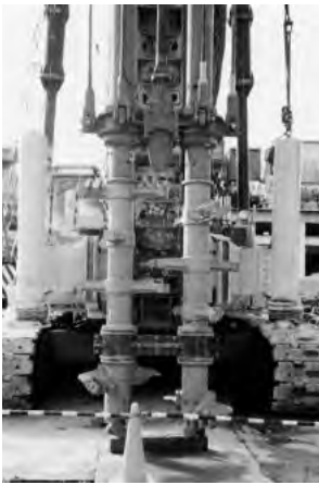
写真6 パペット工法
