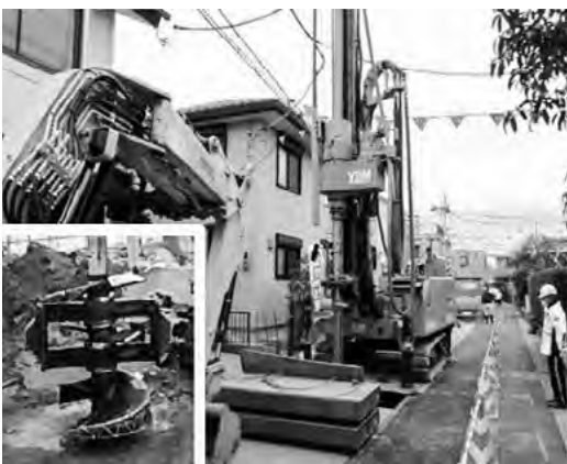
写真7 スマートコラム工法
