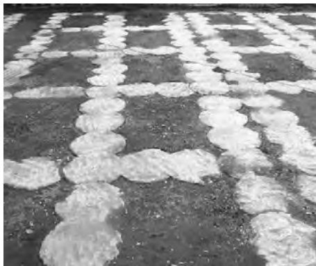
写真3 TOFT工法®(対液状化格子状地盤改良)
