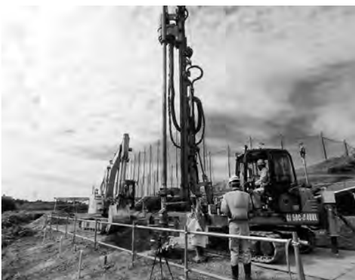
写真8 盛土土肩におけるスマートコラム工法試験施工
