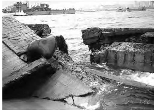
写真2 阪神大震災で無被害のホテルと周辺護岸被害状況
