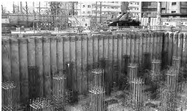
写真4 DOC工法（地盤改良自立土留）
