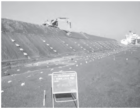
写真4 脱水処理土を使用した築堤施工状況
