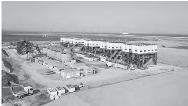
写真3 高圧脱水処理プラント全景
