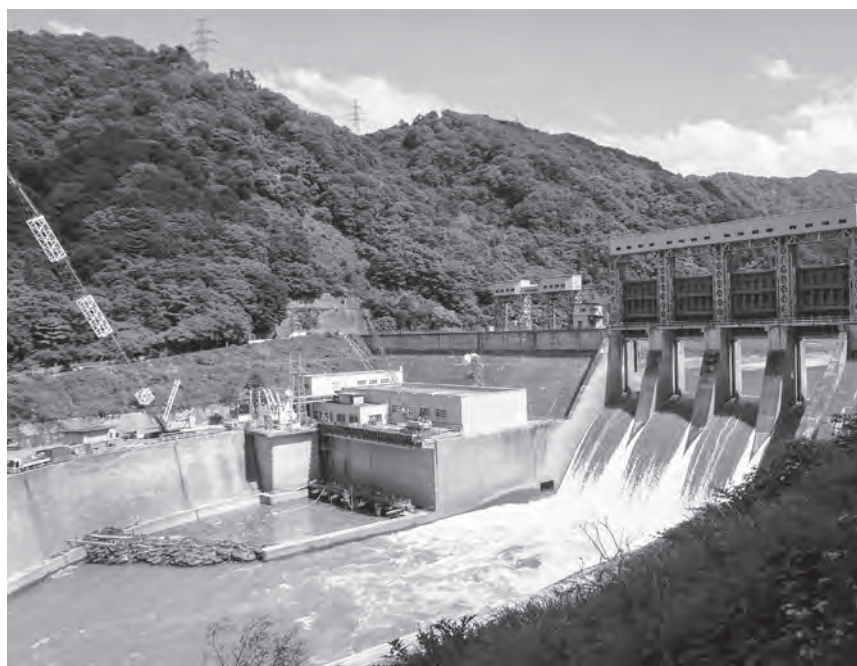
写真2 滝発電所全景
