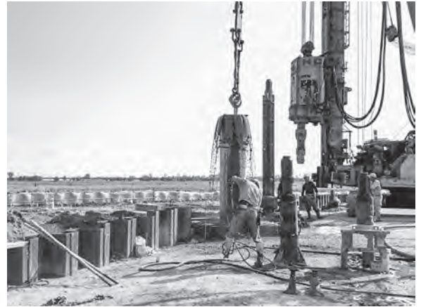
試験杭の施工（杭周固定液のオーバーフロー）
