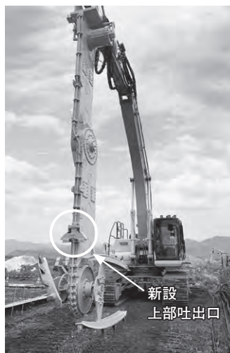
写真2 WILL-m工法施工機械全景
