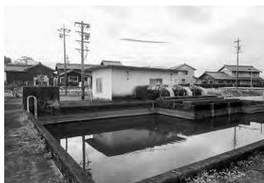
揚水機場 (県営級)
