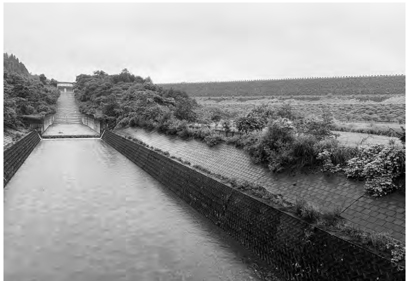
小田ダムの洪水吐と堤体右岸部下流側
