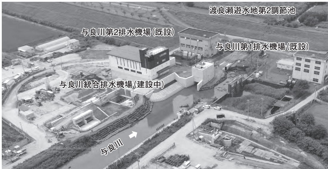
与良川統合排水機場建設工事 全景 (令和4年8月4日撮影)
