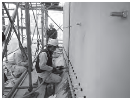
モルタル充填継手の施工(1段目)
