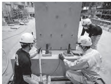
モルタル充填継手の施工
