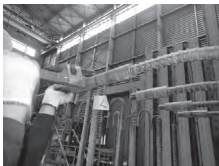
上側軸方向鉄筋の組立て(スリーブ圧着ネジ継手)
