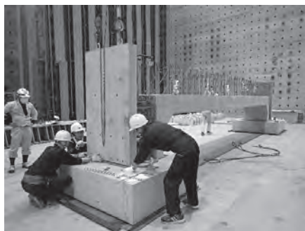
プレキャスト部材の据付
