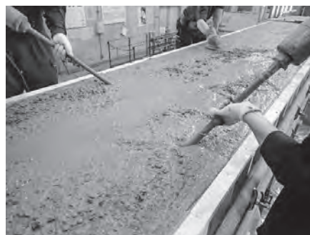
中詰めコンクリート打ち込み
