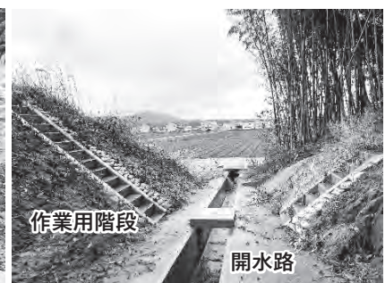
図3a 土砂流出抑制と維持管理施設事例①(廃止ため池B)
