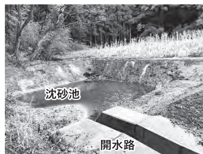
図3a 土砂流出抑制と維持管理施設事例①(廃止ため池B)
