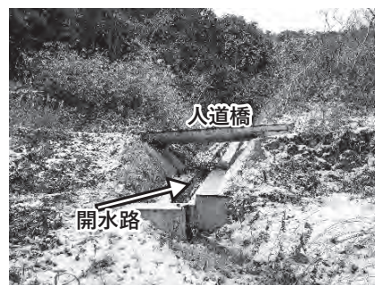
図5 人道橋設置事例(廃止ため池F)
