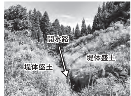
図2 素掘りでの開水路事例(廃止ため池A)
