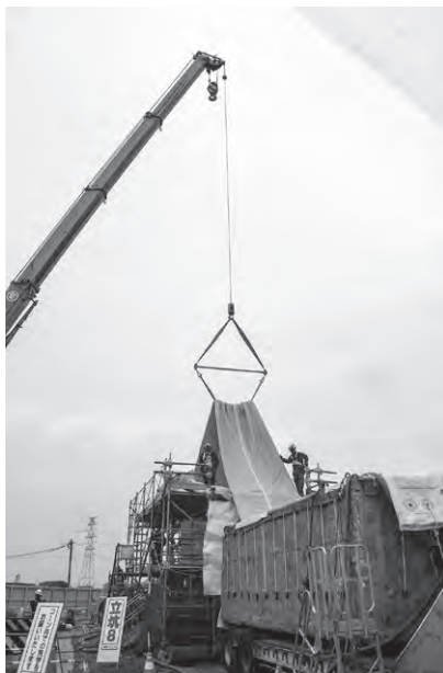
写真3 立坑に設置されたタワーから既設管内に 繰り入れられるライナーバッグの状況
