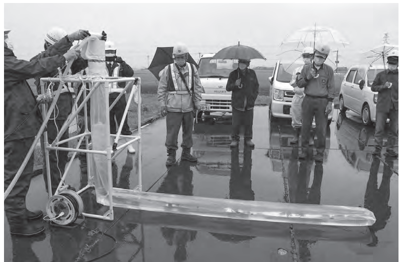
写真3 立坑に設置されたタワーから既設管内に 繰り入れられるライナーバッグの状況
