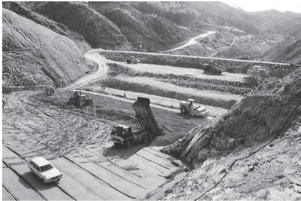
目谷ダム築堤状況
