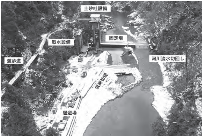
抱返頭首工工事現場の上流から見た全景
