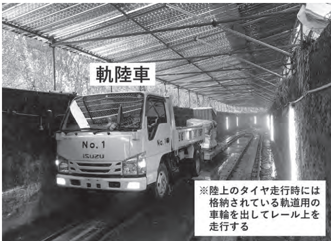
軌陸車（シャーシ下部に軌道用車輪有り）による水路内の資材運搬状況
