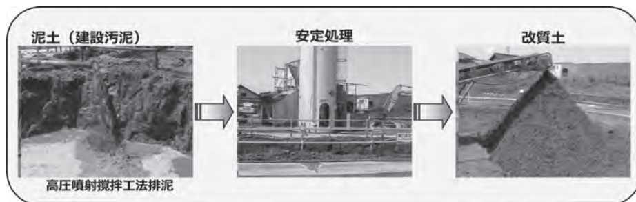
写真1 泥土処理状況
