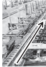
図5 ステップ2：鉄筋運搬
