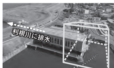
手賀排水機場の新設予定地
