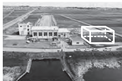
手賀第二揚排水機場の新設予定地
