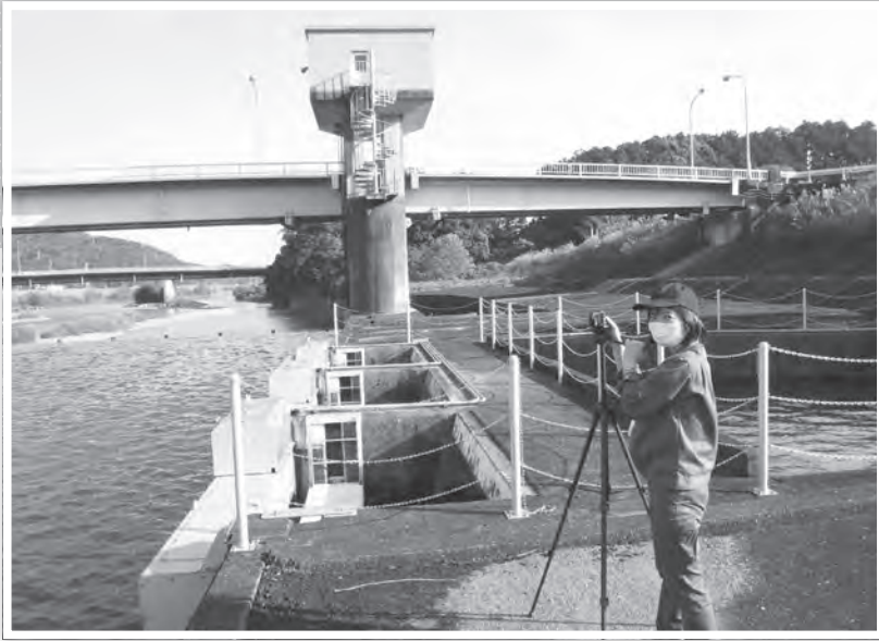
現地調査の様子
