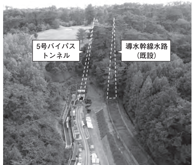
5号バイパストンネル上流側全景
