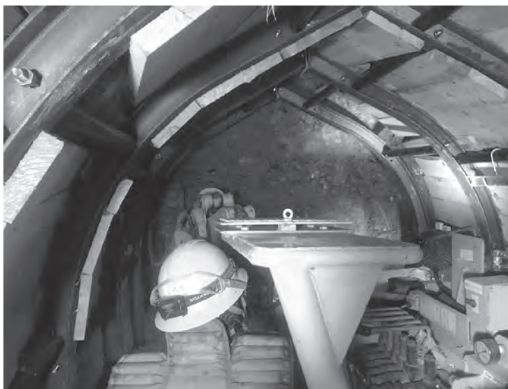
5号バイパストンネル掘削状況
