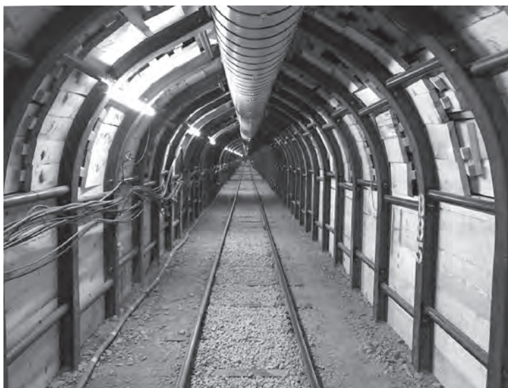
5号バイパストンネル坑内写真
