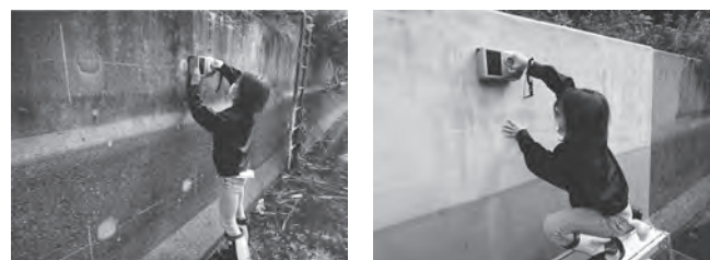
写真1 現地試験の状況
