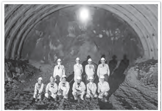
香川県でのトンネル工事貫通時（前列一番左）
