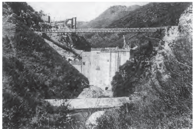
工事中の小坂部川ダム
