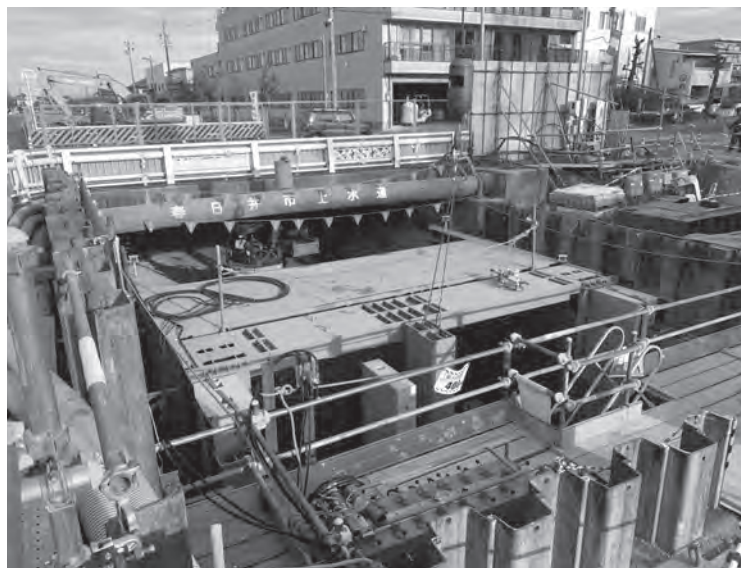
オープンシールド掘進状況 橋梁下
