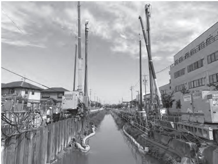
2期工事鋼矢板打設状況（かんがい期施工）
