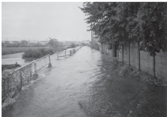
新木津用水路 溢水被害状況
