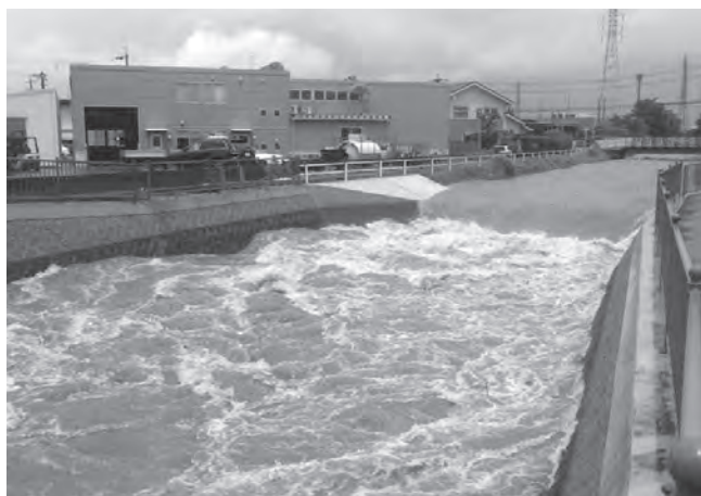
新木津用水路改修状況（上流：改修前、下流：改修済）
