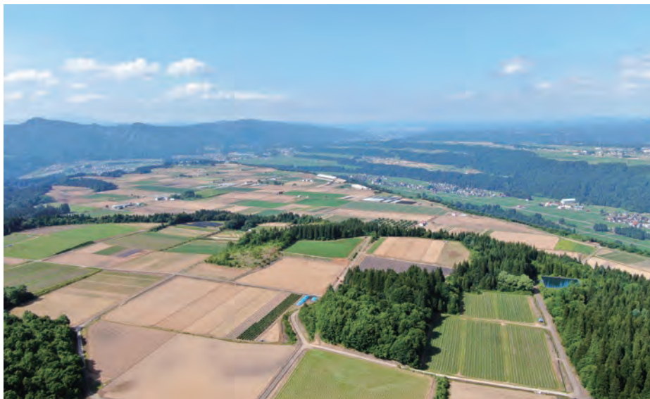
国営農地開発事業（苗場山麓地区）で整備された圃場
