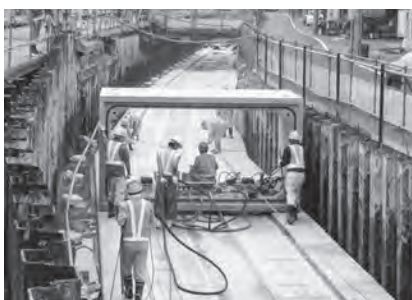
写真2 人力による移動
