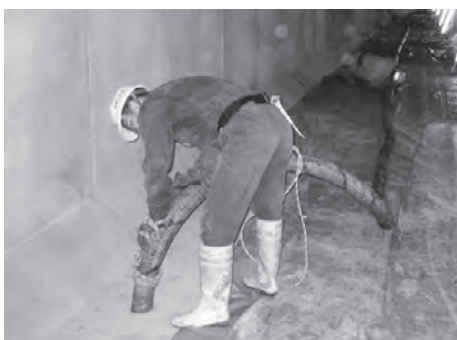
写真6 切込み部モルタル充填
