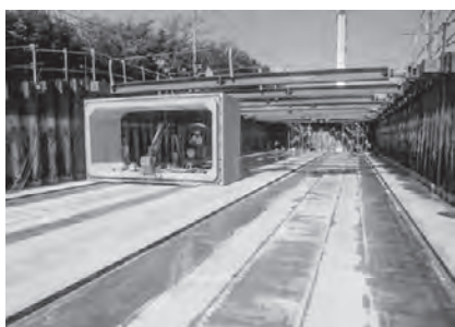
写真3 バックホウによる移動
