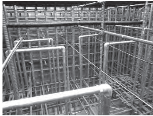
写真3 クーリングパイプ設置状況
