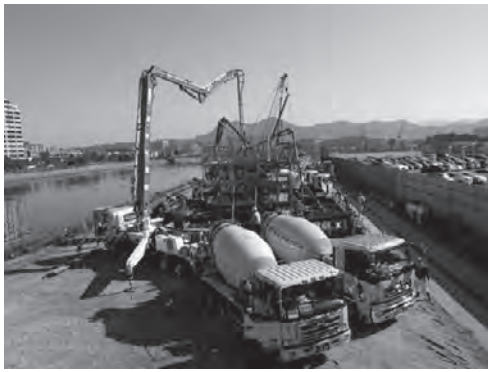
写真4 コンクリート打設状況
