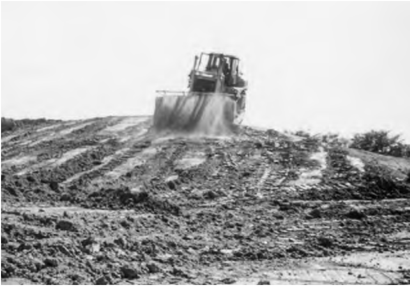
含水比調整ブルドーザ作業状況
