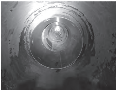
巻き込み鋼管運搬
