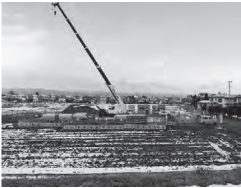
鋼管吊込み状況
