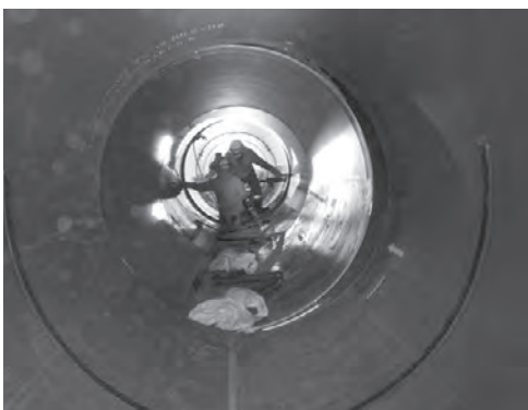
巻き込み鋼管据付状況
