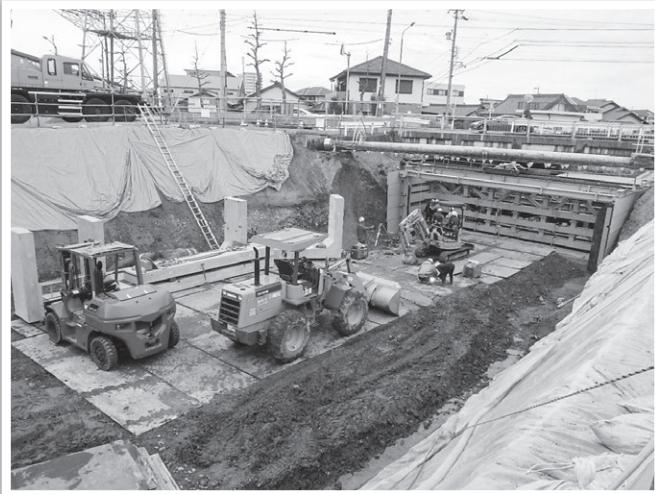
工事は、河川改修区間約130mで既設水路を取壊し、新たに護岸工(ブロック積854m<sup>3</sup>)、底版工100m、プレキャストL型擁壁水路工30mを構築します。工事現場上空には、東名高速道路・中圧ガス管(400A)・水道管(Φ500mm、2箇所)・市道橋梁が近接しているほか、民家に隣接するなど厳しい制約条件下での施工となっています。周辺は、交通渋滞の多い生活道路となっているため、工事施工に伴う騒音・振動・粉塵には十分配慮した施工に心掛け、営農作業に支障を来たさぬよう、3月末の通水開始に向けて職員・協力会社一丸となって災害ゼロでの工期内竣工を目指しています。
